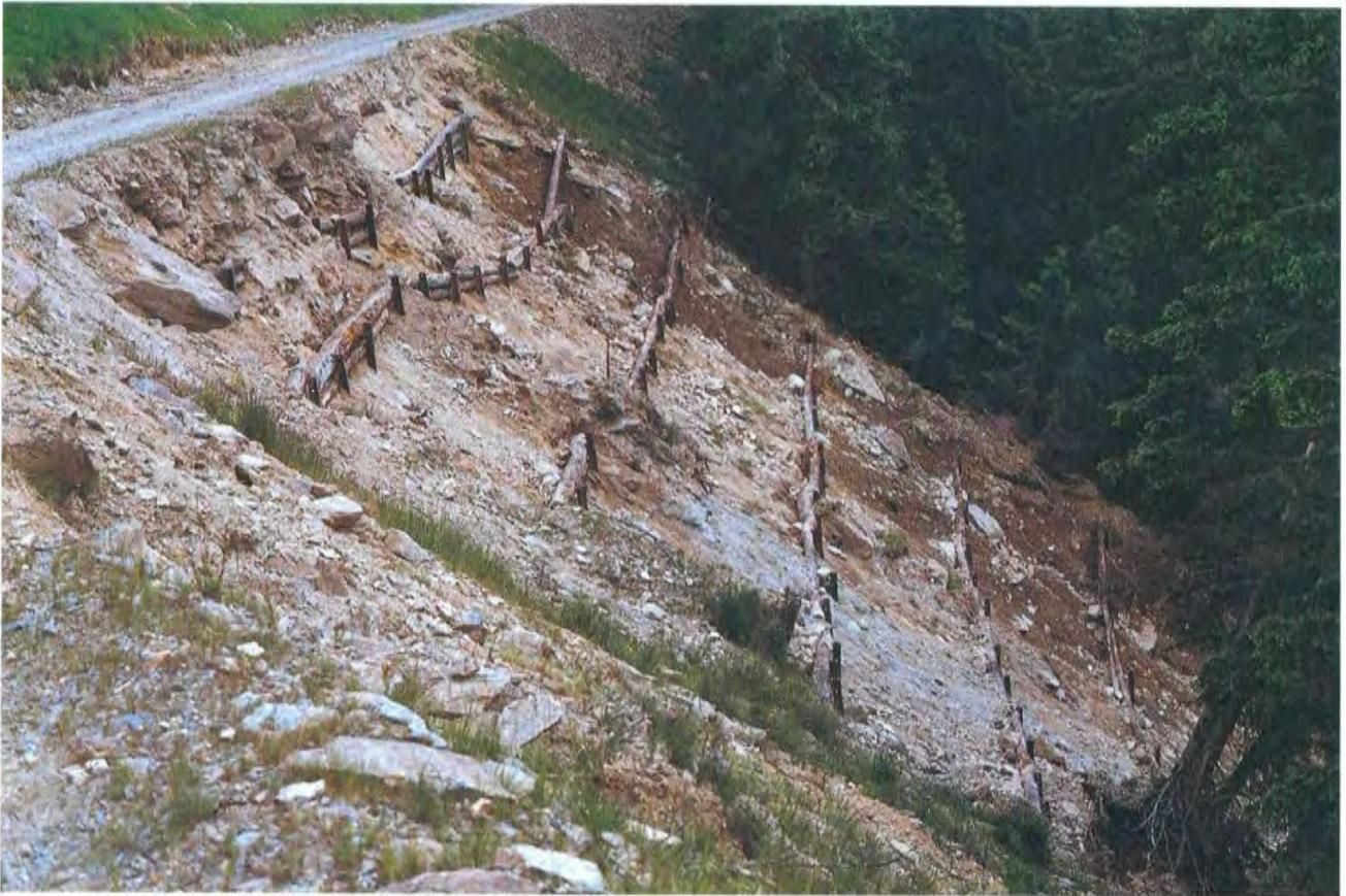
TAV. N. 21 *Palizzata in legname ed inerbimento con coltre protettiva di paglia e bitume (fase di realizzazione)*
