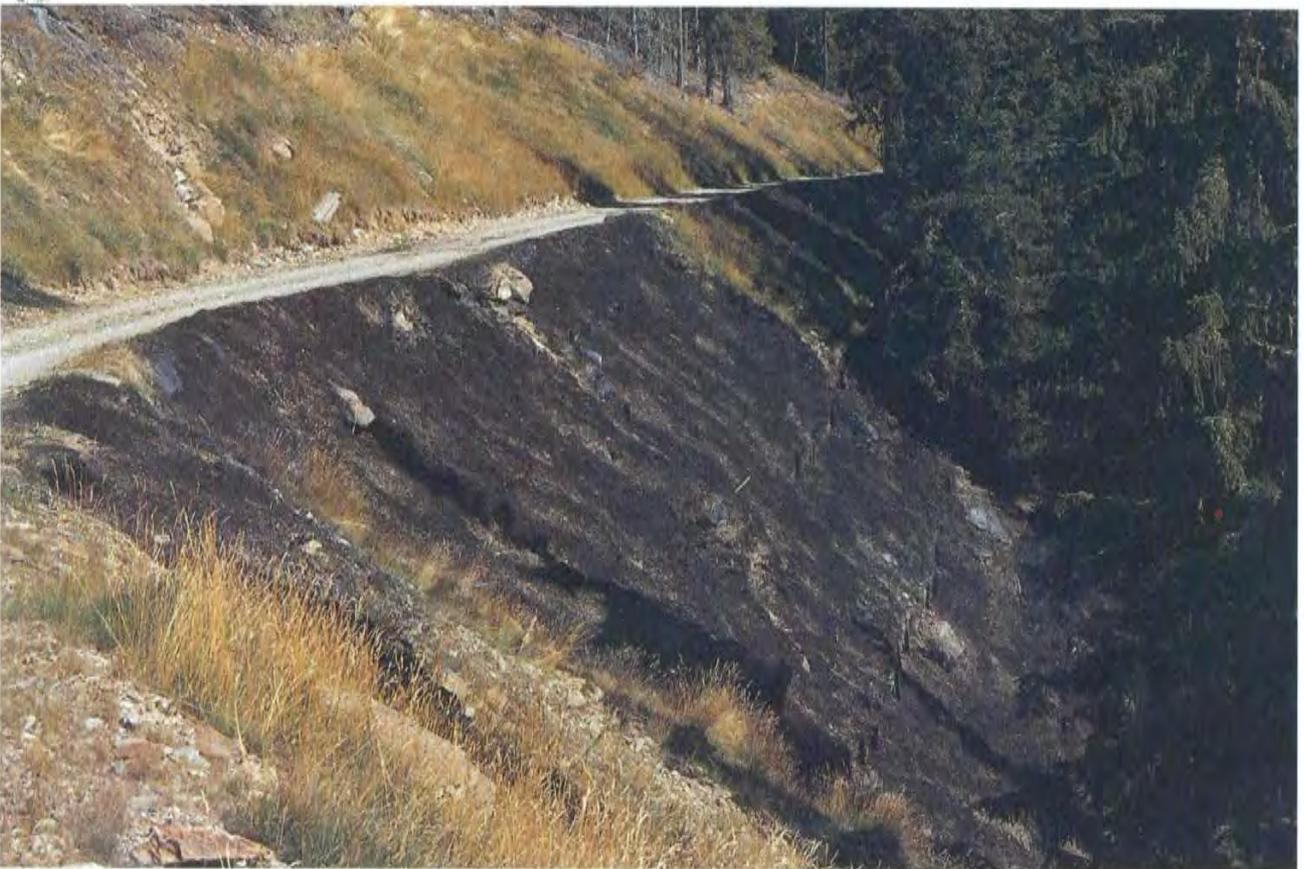
TAV. N. 22 *Palizzata in legname ed inerbimento con coltre protettiva di paglia e bitume (fase di realizzazione)*
